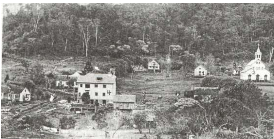
Figura 2: Igreja enxaimel do núcleo comunitário da Vila São João em 1953, ponto focal da paisagem. Fonte: Casa da Cultura de São João do Oeste, 2020.
