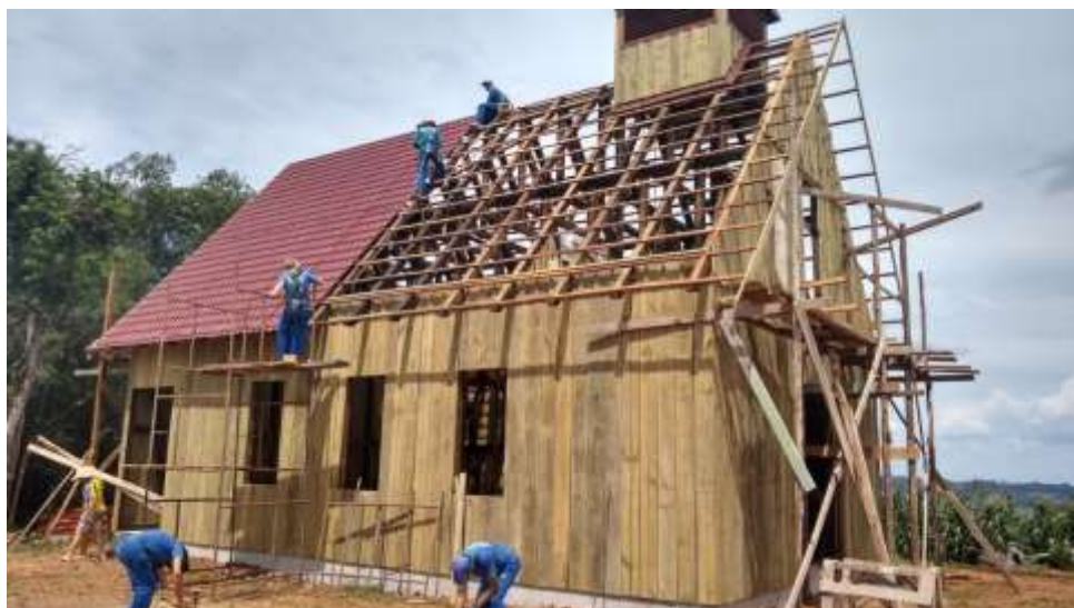
Figura 11: Detalhes da colocação do telhado e do fechamento com tábuas. Fonte: Simone Eidt, 2019.
