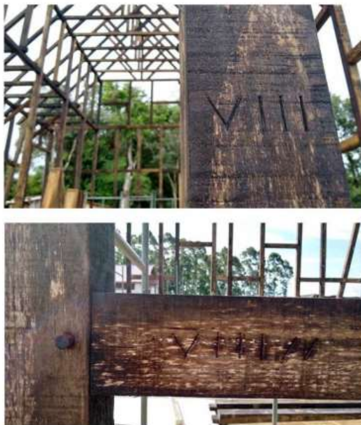
Figura 10: Detalhe da numeração para encaixe das peças. Fonte: Simone Eidt, 2019.
