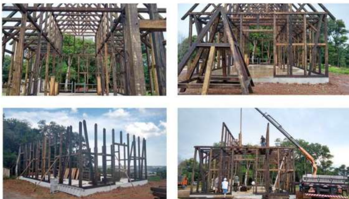
Figura 9: Detalhes da montagem da estrutura. Fonte: Simone Eidt, 2019.
