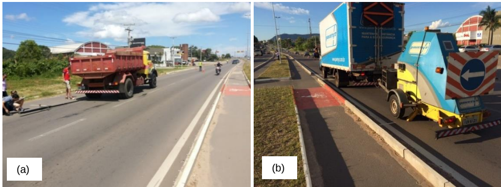
Figura 1 – Realização dos ensaios deflectométricos com a viga benkelman (a) e FWD (b)
