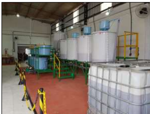
Figura 3 – Galões de armazenamento e filtragem na Cooperativa Fonte: Coordenador do projeto (2020).
