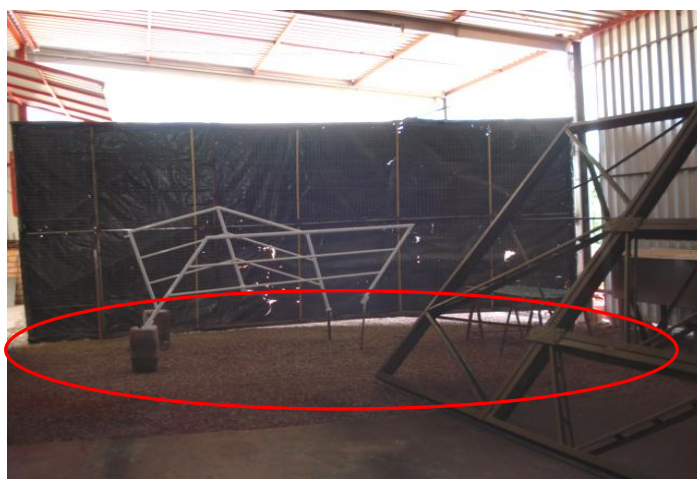
Figura 9. Detalhe da cabine de pintura.
