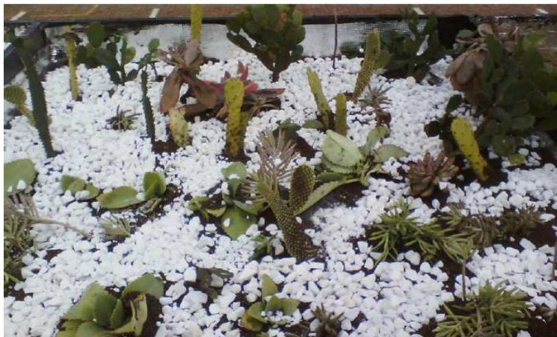
Figura 6: Telhado verde intensivo finalizado com pedriscos.
