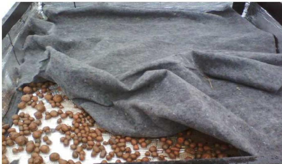
Figura 3: Instalação de argilas expandidas no espaço destinado a receber os telhados verdes extensivos.
