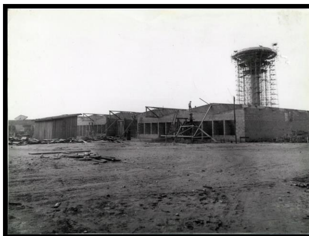
Figura 03: Construção dos prédios e da caixa d'água.
