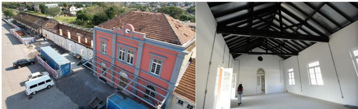
Figura 5 – Fotos: fachada da Gare em reforma e parte interna.
