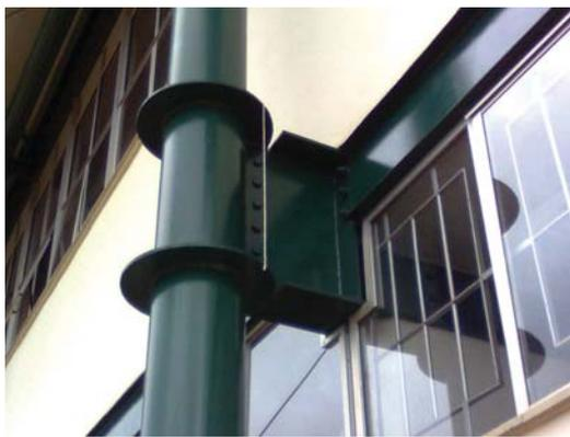
Figura 2: Detalhe da ligação da coluna tubular com a viga principal de seção “I”.
