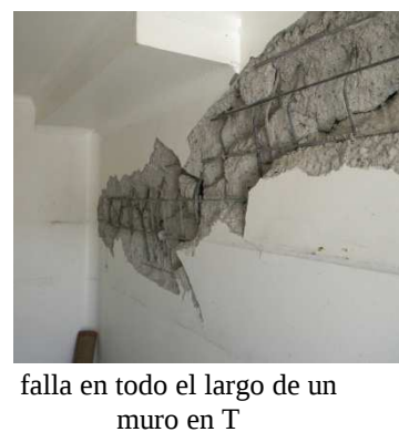
Figura 4: Edificios habitacionales de la ciudad de Santiago con daño severo en el nivel de estacionamientos: (a) edificio A (falla en nivel -1); y (b) edificio B (falla en nivel 1).
