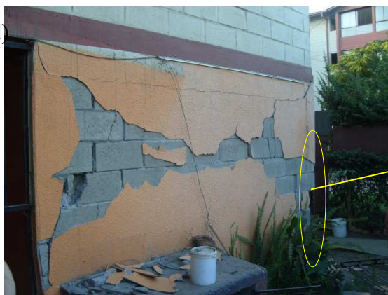
Figura 8: Complejo habitacional de albañilería armada de bloques de cemento de 4 y 5 pisos de altura, en la ciudad de Rancagua. (a) vista aérea de los edificios dañados y su entorno; (b, c) fallas por corte en el mortero de junta; (d, e) falla por corte en el mortero de junta y en los bloques de cemento.
