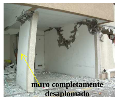
Figura 4: Edificios habitacionales de la ciudad de Santiago con daño severo en el nivel de estacionamientos: (a) edificio A (falla en nivel -1); y (b) edificio B (falla en nivel 1).
