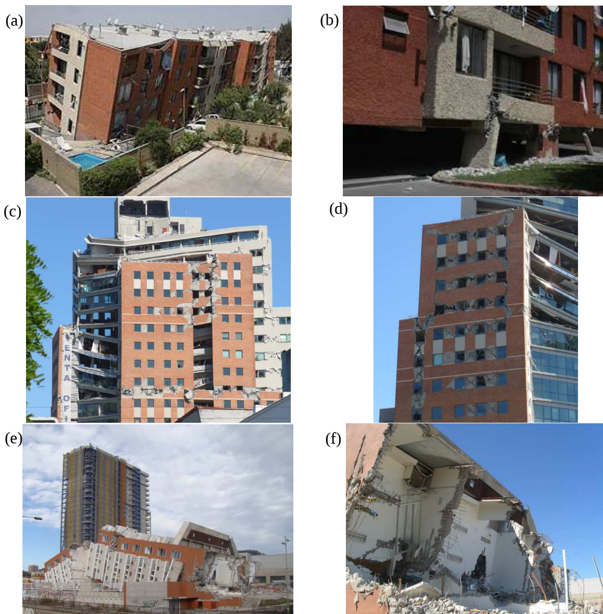
Figura 6: Edificios de H°A° colapsados durante el terremoto del 27F: (a, b) Condominios Don Tristán y Don Luis (Santiago); (c, d) Torre O'Higgins (Concepción); y (e, f) Edificio Alto Río (Concepción).
