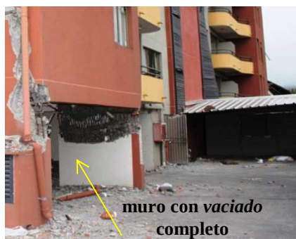
Figura 5: Edificios habitacionales de la ciudad de Concepción con daño severo en el nivel de estacionamientos: (a) edificio C; y (b) edificio D. (Fotos: Gilda Espinoza y Alvaro Suazo).
