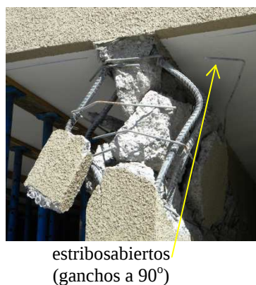
Figura 4: Edificios habitacionales de la ciudad de Santiago con daño severo en el nivel de estacionamientos: (a) edificio A (falla en nivel -1); y (b) edificio B (falla en nivel 1).
