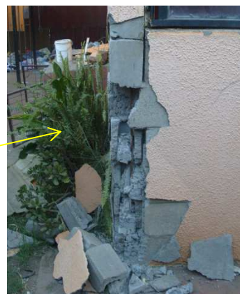
Figura 8: Complejo habitacional de albañilería armada de bloques de cemento de 4 y 5 pisos de altura, en la ciudad de Rancagua. (a) vista aérea de los edificios dañados y su entorno; (b, c) fallas por corte en el mortero de junta; (d, e) falla por corte en el mortero de junta y en los bloques de cemento.
