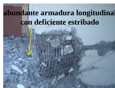
Figura 5: Edificios habitacionales de la ciudad de Concepción con daño severo en el nivel de estacionamientos: (a) edificio C; y (b) edificio D. (Fotos: Gilda Espinoza y Alvaro Suazo).
