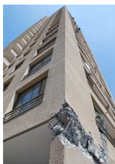
Figura 4: Edificios habitacionales de la ciudad de Santiago con daño severo en el nivel de estacionamientos: (a) edificio A (falla en nivel -1); y (b) edificio B (falla en nivel 1).
