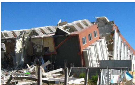
Edificio A, Concepción
