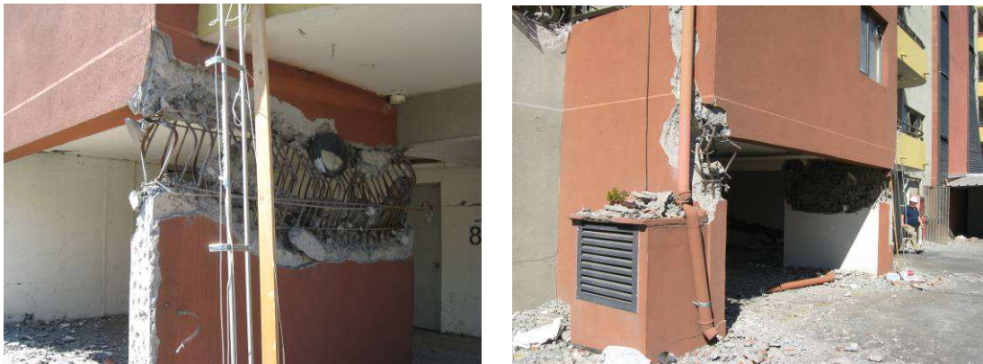
Figura 9: Alargamiento de armaduras en muro bajo muro discontinuo, Edificio B.
