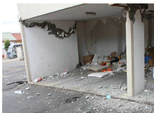
Edificio D Concepción
