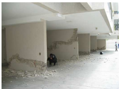
Edificio C Viña del Mar
