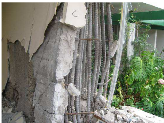
Figura 7: Daños en muros de un edificio chileno típico que pasó relativamente bien el terremoto del 3 de marzo de 1985 y que fue reparado posteriormente.
