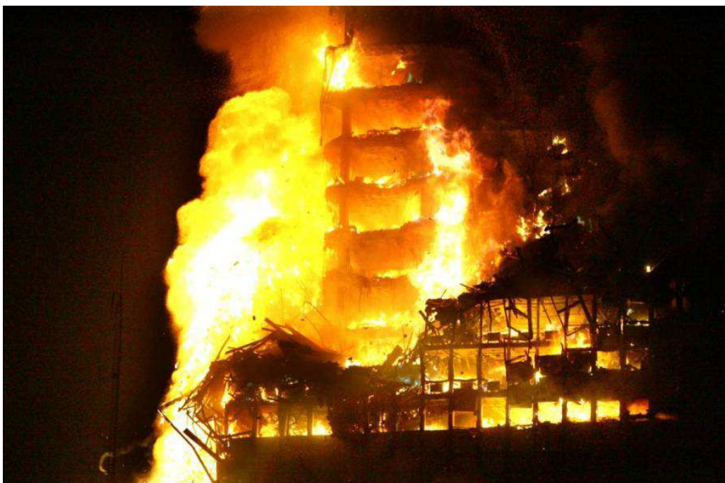
Figura 3: Fotografia do incêndio e consequente colapso generalizado da Torre Windsor em Madrid, em 2005.
