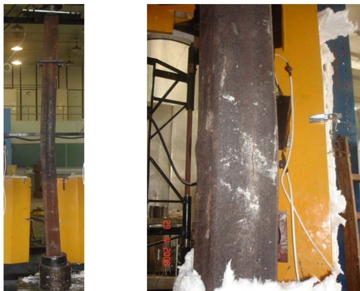
Figura 3: Rupturas típicas dos pilares, instabilidade global e local
