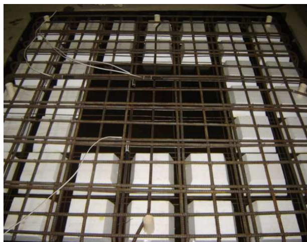
Figura 2: Posicionamento das armaduras de flexão
