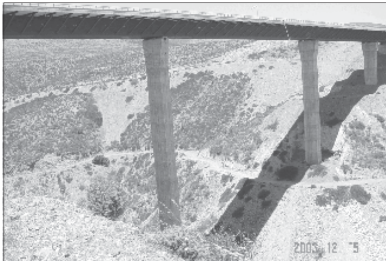
Figura 2: Vista general Puente Amolanas
