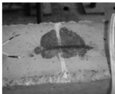
Figura 5: Posicionamento dos extensômetros no concreto
