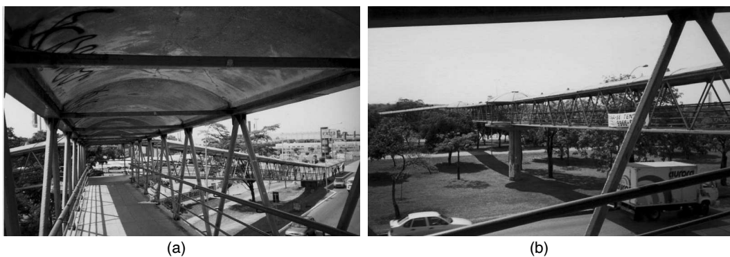
Figura 6: Fotos da passarela sobre a Epia: (a) vão inclinado, (b) vão horizontal
