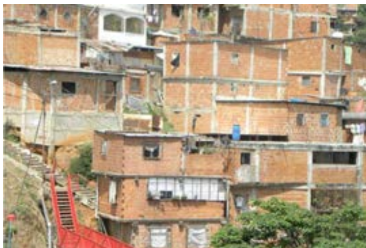
Figura 1: Construcciones informales en las que se aprecia la irregularidad tanto en planta como en elevación
