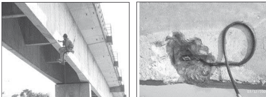
Figura 4: Fixação de extensômetros na parte inferior da longarina.
