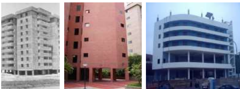
Figura 1 – Piso blando en la primera planta [1]
