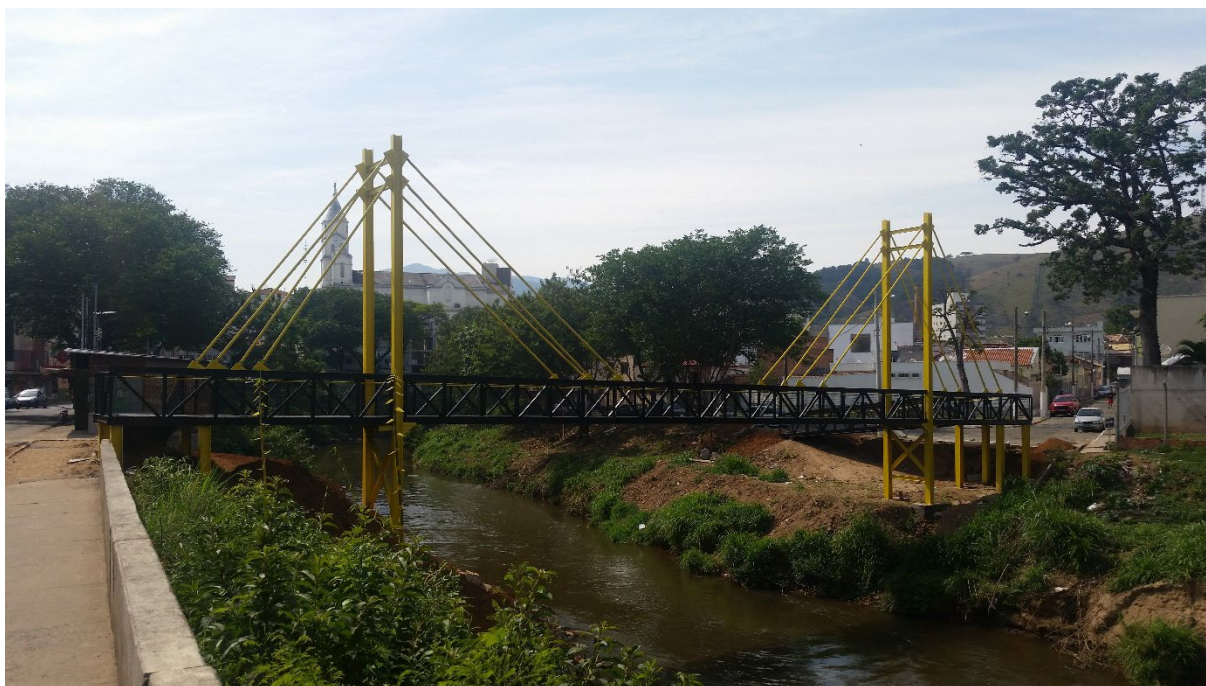
Figura 2 – Vista da passarela a partir da Rua Aurílio Lopes Ramos.
