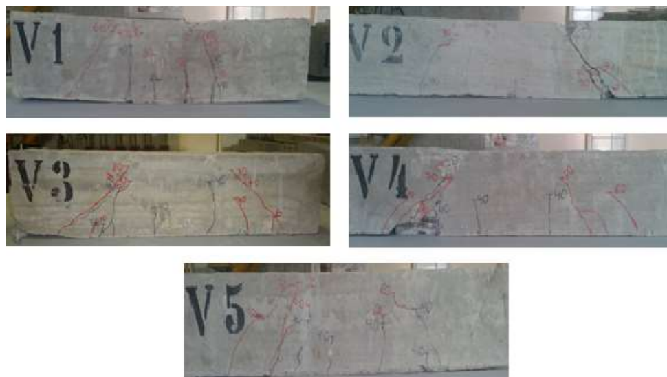
Figura 7 - Vigas V1, V2, V3, V4 e V5 após ruptura.
